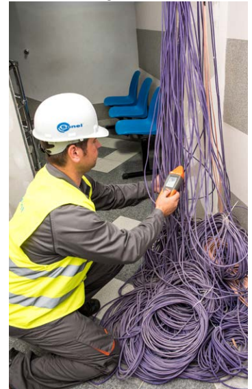
...und Zustand direkt vor der Verlegung
